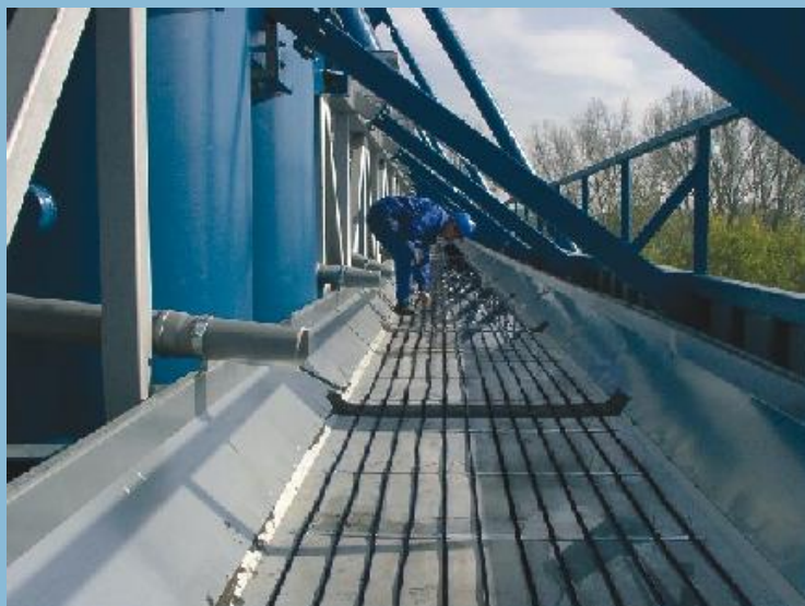
Przykład ułożenia przewodów grzejnych w korycie dachowym
